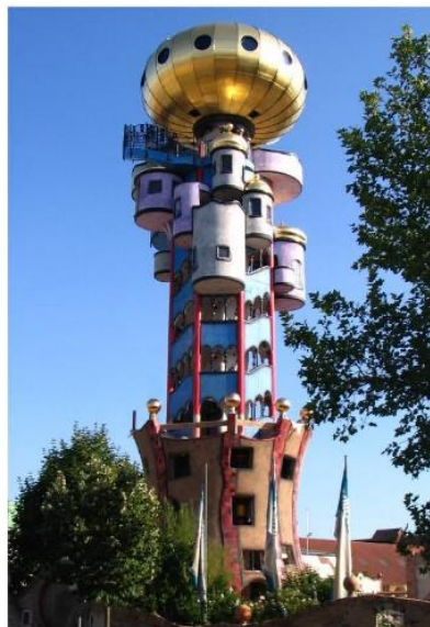
Kuchlbauer-Turm de Friedensreich Hundertwasser à Abensberg (Allemagne)
